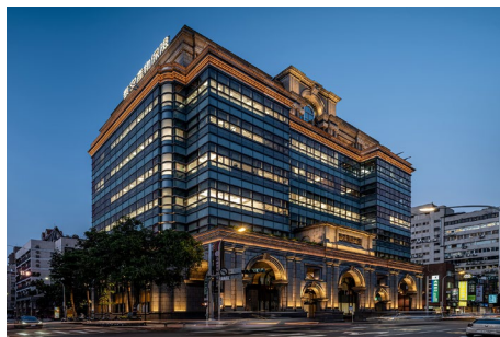
台北 泰安產險大樓
